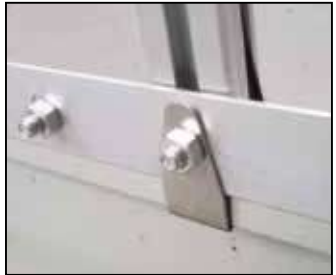
Crochet à positionner Haken anbringen Attach hook
